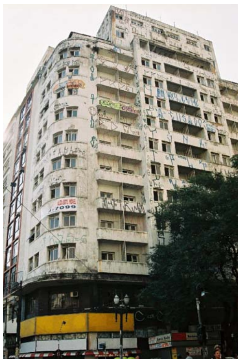
Foto 3.8: Edificação que foi palco de ocupação em 2003. A autora: Bomfim, 2003.
