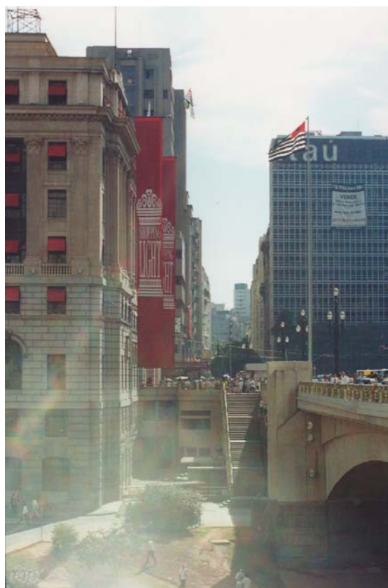
Vista do Viaduto do Chá para a Rua Cons. Crispiniano. autora: Bomfim, 2001
