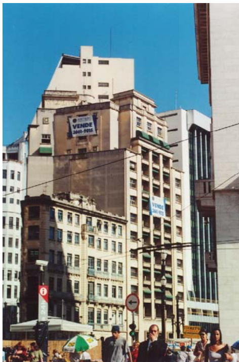
Vista da rua Líbero Badaró e rua Falcão Filho. Autora: Bomfim, 2001.
